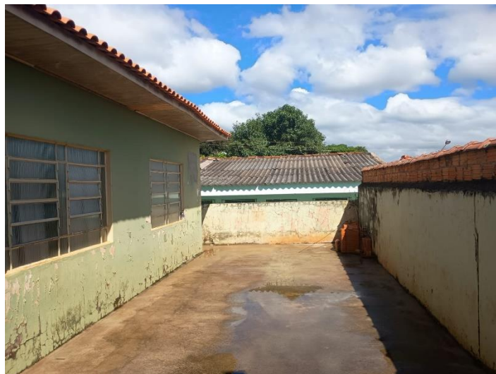
FOTO 17 – FUNDO DO PRÉDIO
