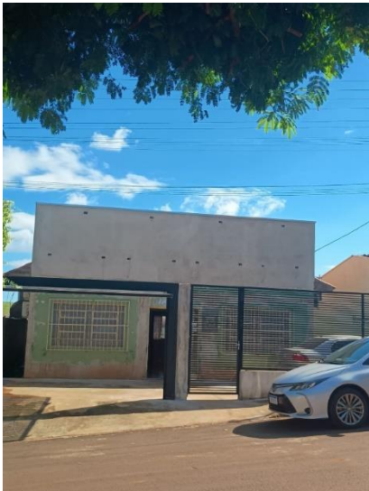
FOTO 1 – FACHADA DO PRÉDIO
