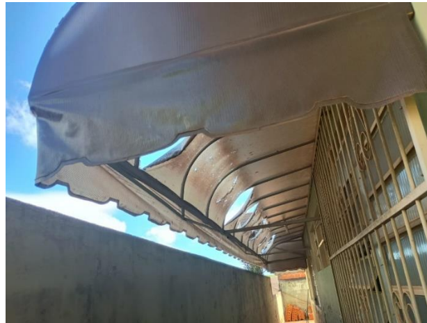
FOTO 16 – LATERAL ESQUERDA DO PRÉDIO
